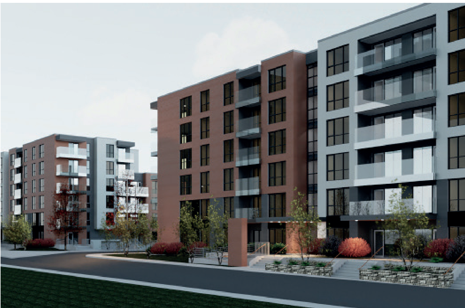
Fondations du Quartier Phase II | Source: Campanella & ass.
